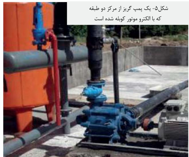
شکل ۵- یک پمپ گریز از مرکز دو طبقه که با الکترو موتور کوبله شده است
