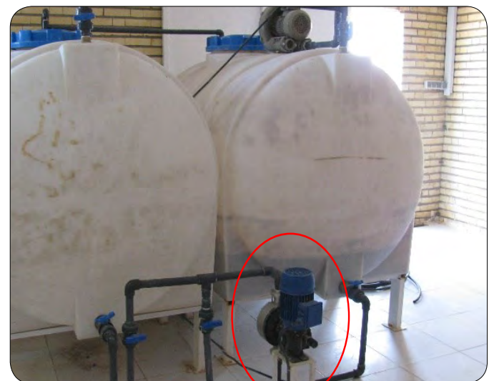
شکل ۴- مخزن های کود با تزریق کننده ضربه ای و دمنده هوا جهت هم زدن و انحلال کامل کود (سمت راست) و تزریق کود با استفاده از پمپ دیافراگمی با استفاده از نیروی مکش سیستم آبیاری (سمت چپ)
